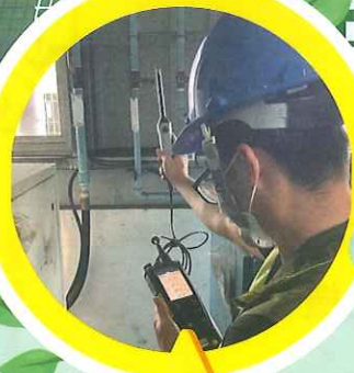
設備機房溫度檢測
